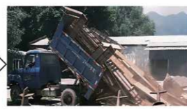
对旧的和未使用的浇筑混凝土模板进行回收
