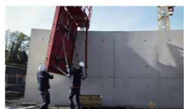
浇筑混凝土用的模板
