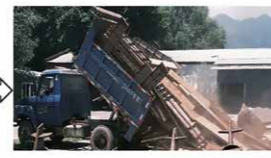
Récupération des banche à béton Usagées et non utilisables
