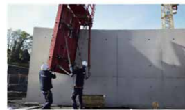
Banche à béton
